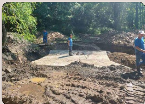
Vodotok Grujinac – naselje Branešći Vrijednost radova: 7.006,58 €
