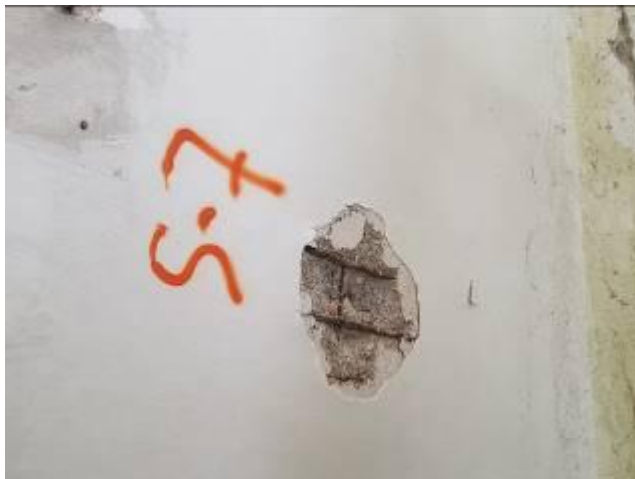
Slika 14. Prikaz sonde S7
