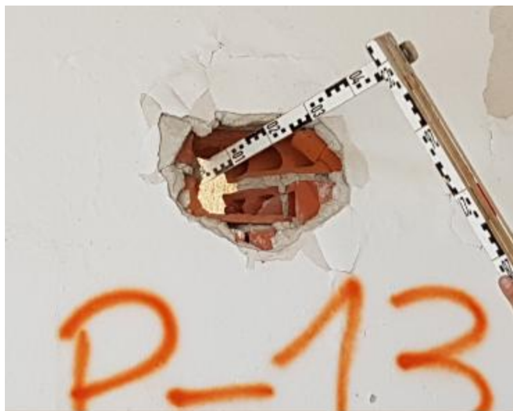
Slika 32. Izmjera zida P13
